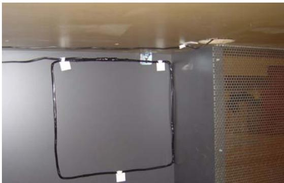
Die Schleife muss **vertikal** an der Front des Schalters auf der Innenseite angebracht werden.
